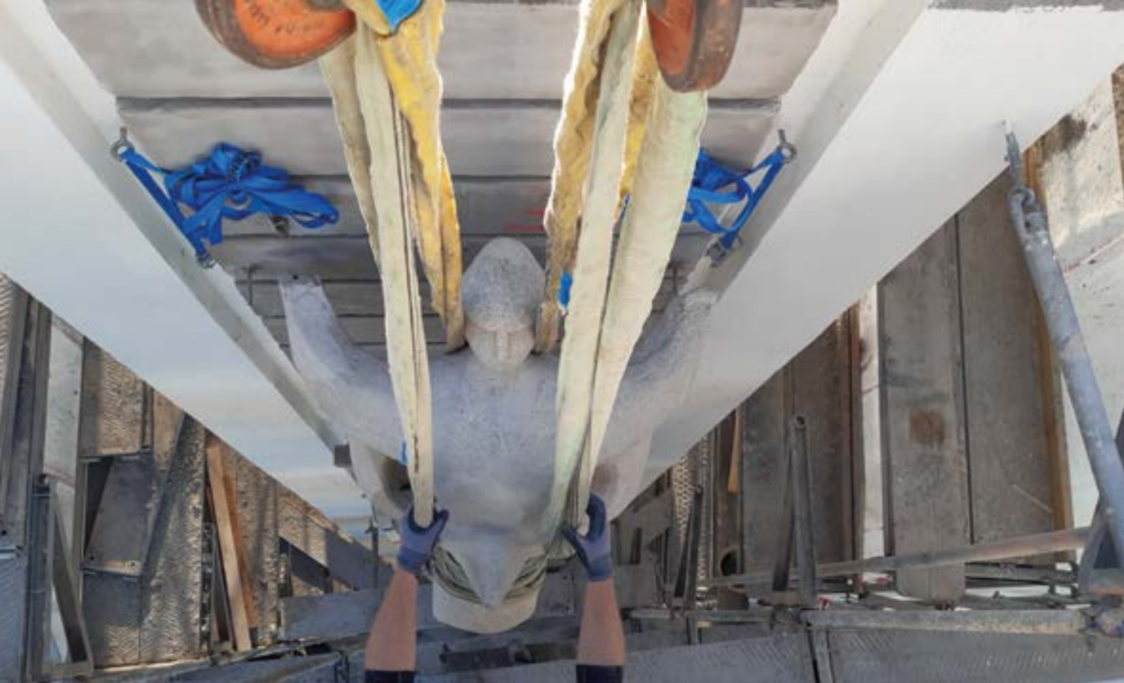
Restaurierungsarbeiten an den Betonskulpturen am Kirchturm der Pfarrkirche Herrnau, Salzburg
