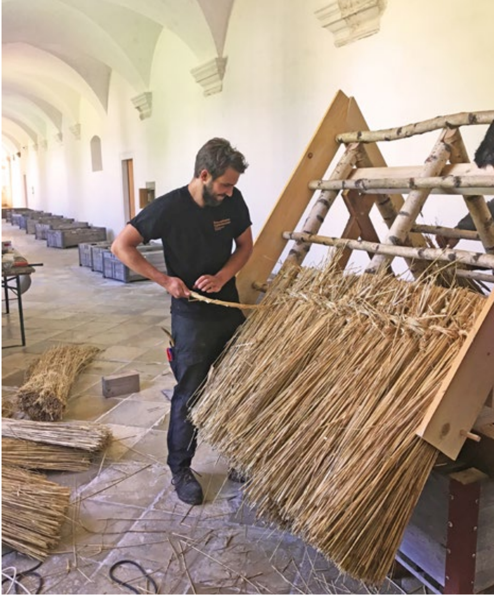
Strohdachdeckung, Kreuzgang der Kartause Mauerbach
